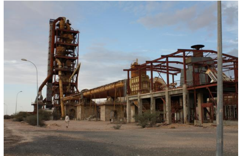
15a) Rotary furnace
