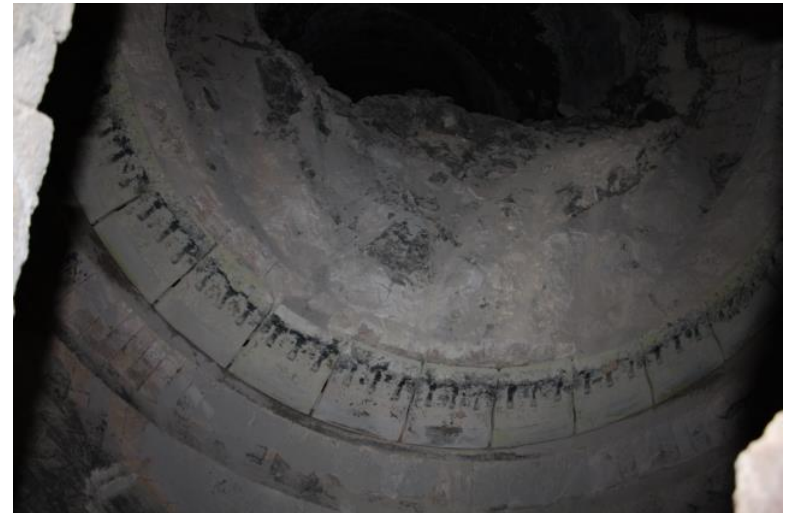
49) Lining – swipe furnace
