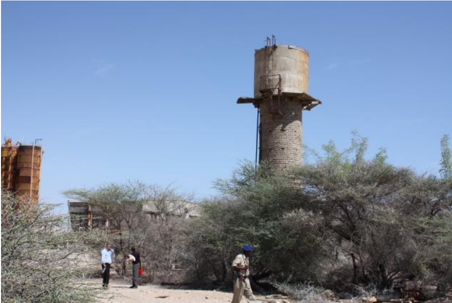
84) The Water Tank
